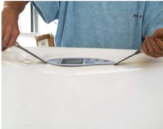
Das Bedienteil durch Unterspreizen mit zwei Stechbeiteln vorsichtig aus der Ausfräsung hebeln. Um die Oberfläche nicht zu beschädigen, eine Unterlage aus Gummi, Stoff oder ähnlichem verwenden.
