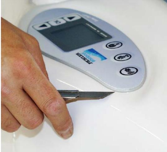
Die Silikonfuge unter dem Rand des Bedienteils mit einem Teppichmesser aufschneiden.
